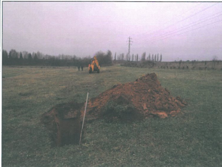
Místo kopané sondy a charakter výkopku
