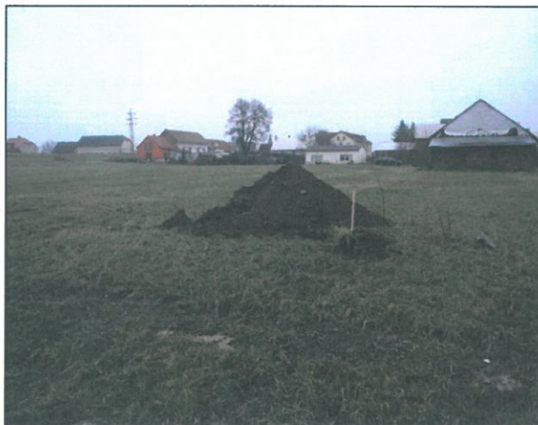
Místo kopané sondy a charakter výkopku
